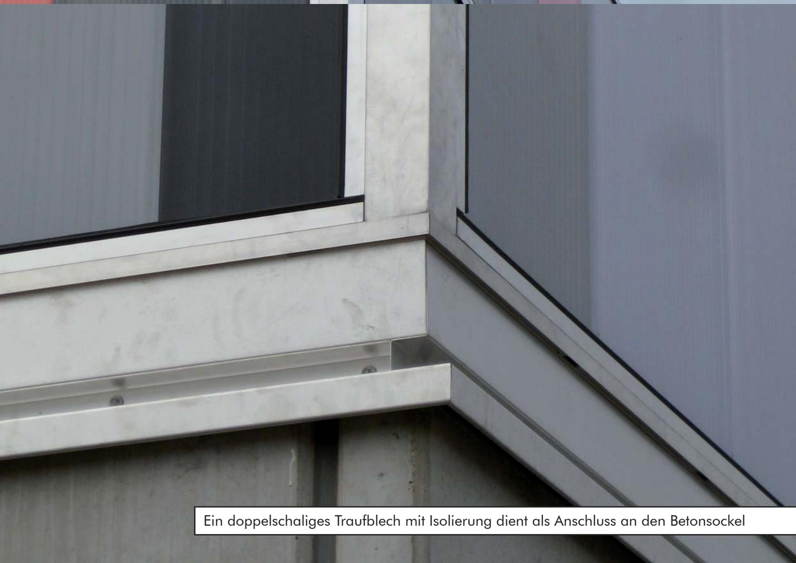
Ein doppelschaliges Traufblech mit Isolierung dient als Anschluss an den Betonsockel
