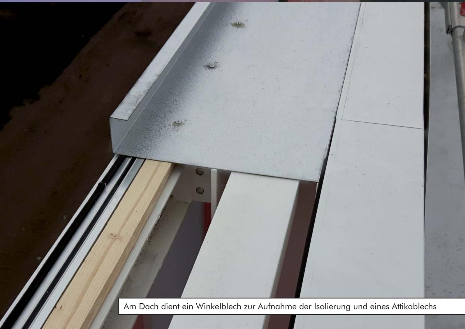
Am Dach dient ein Winkelblech zur Aufnahme der Isolierung und eines Attikablechs
