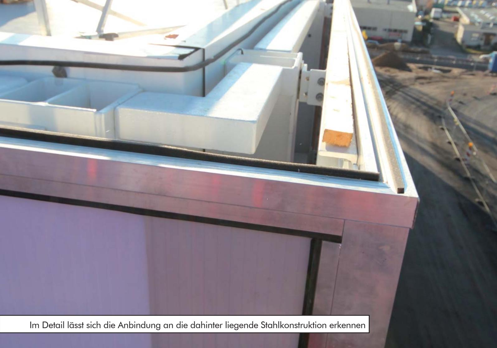
Im Detail lässt sich die Anbindung an die dahinter liegende Stahlkonstruktion erkennen
