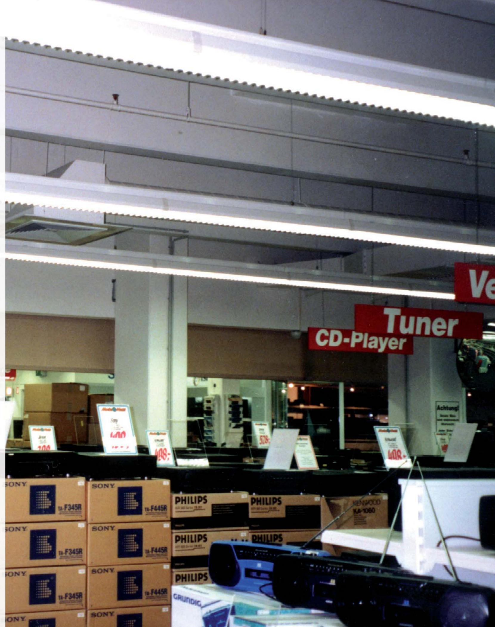
Bild: Auch in großflächigen Fachmärkten mit Publikumsverkehr müssen Rauchschürzen installiert werden
