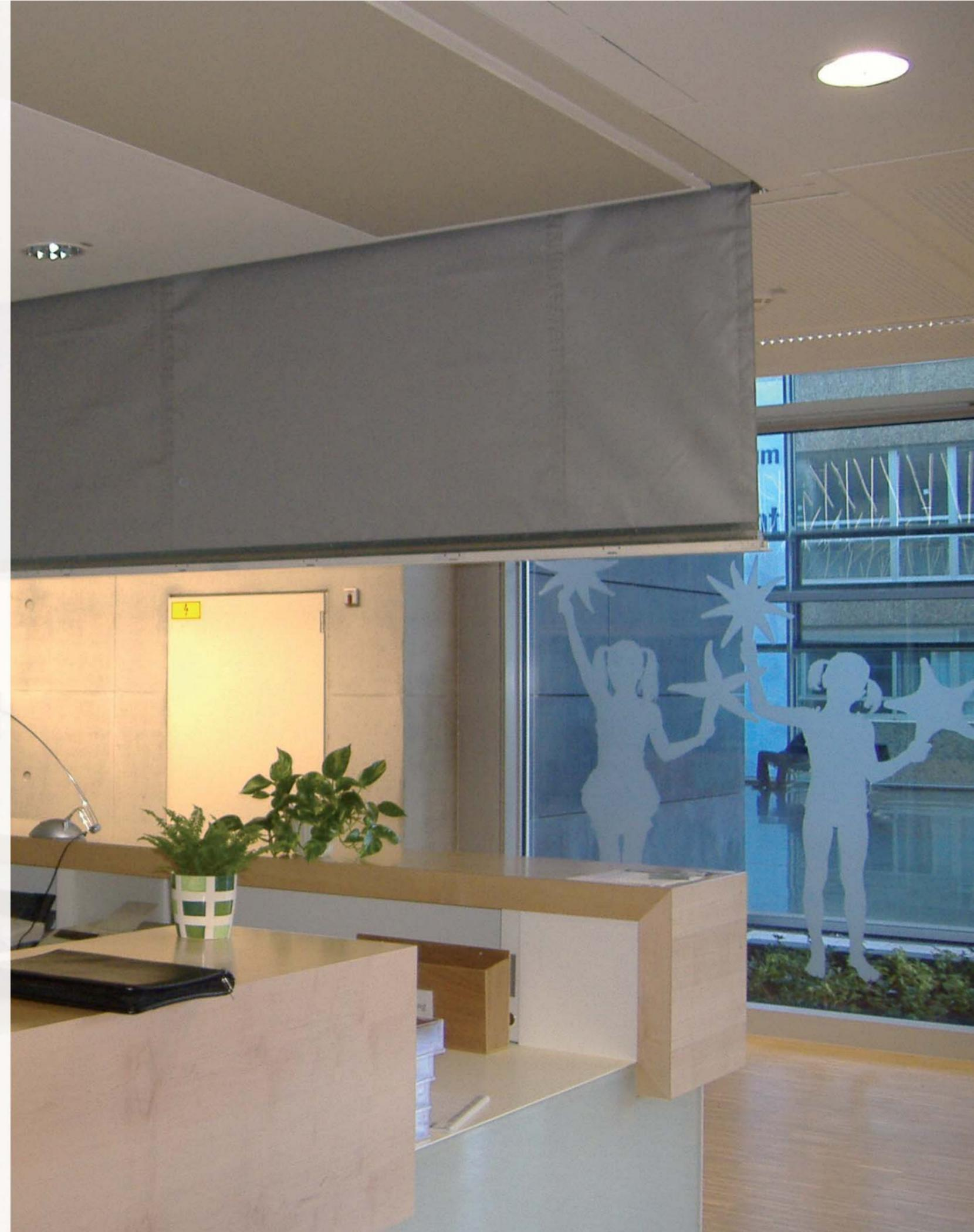
Bild: Nur im Brandfall werden die Rauchschrzen ausgefahren
