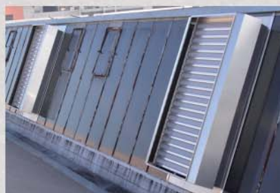
Schräge Einbaulage im Sheddach
