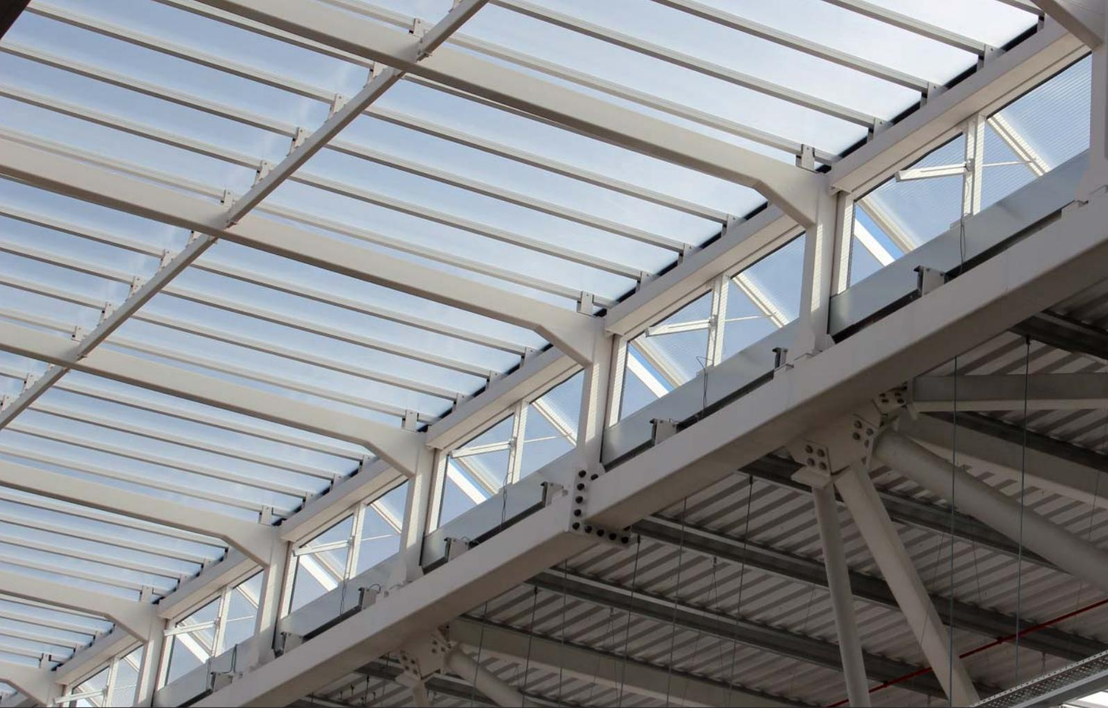
Licht fällt sowohl über das Dach als auch über die seitlichen Lüftungsflächen der Dachlaternen ins Gebäude
