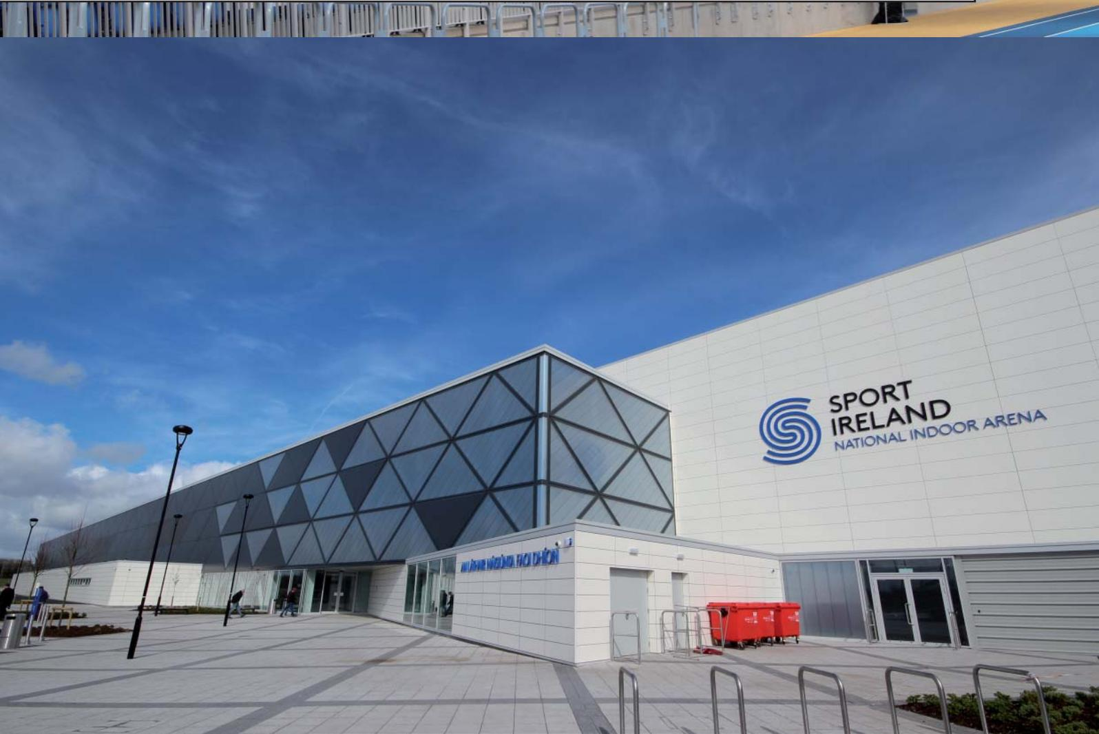
Teile der Fassade bestehen aus lichtdurchlässigen Polycarbonat-Mehrstegplatten.
