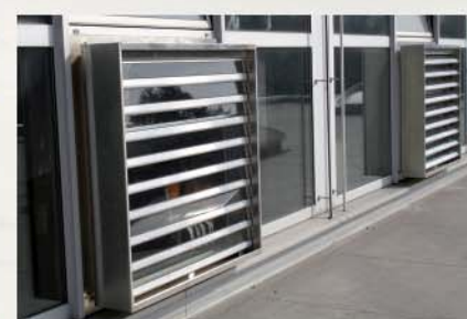
Mit Isolierglas ausgefachte SMOKEJETs
