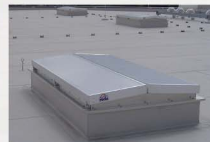
Einzelgeräte auf einem Industriedach
