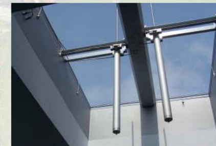
FIREFIGHTER DELTA mit Isolierverglasung
