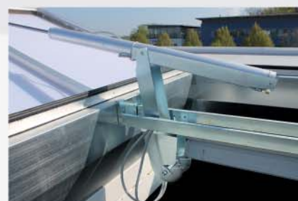
Pneumatischer Antrieb mit einem Zylinder
