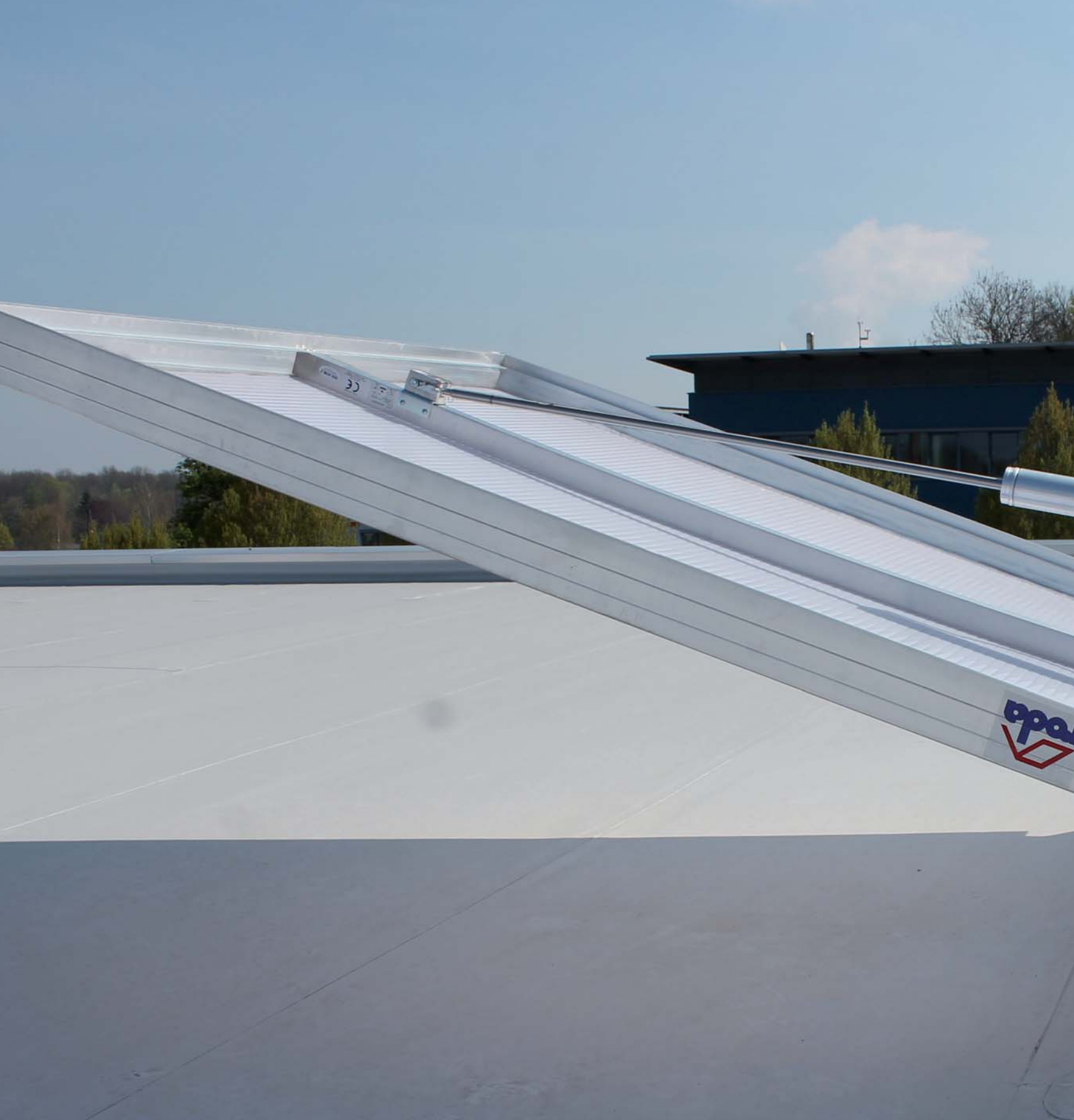
Großes Bild: NRW Typ VenturiSmoke VS1 für die jährliche Wartung zur Brandlüftung geöffnet
