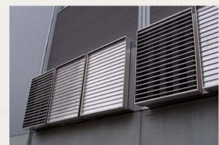
SMOKEJETs als seitliche Zuluftöffnung
