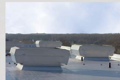
Gewährleisten Lüftung auch bei Regen
