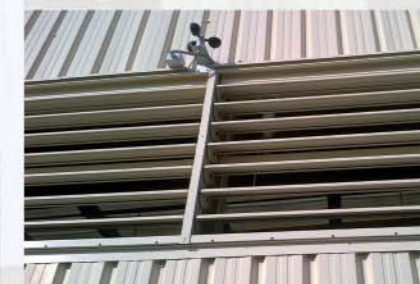
AIRJET schließt bei zu starkem Wind
