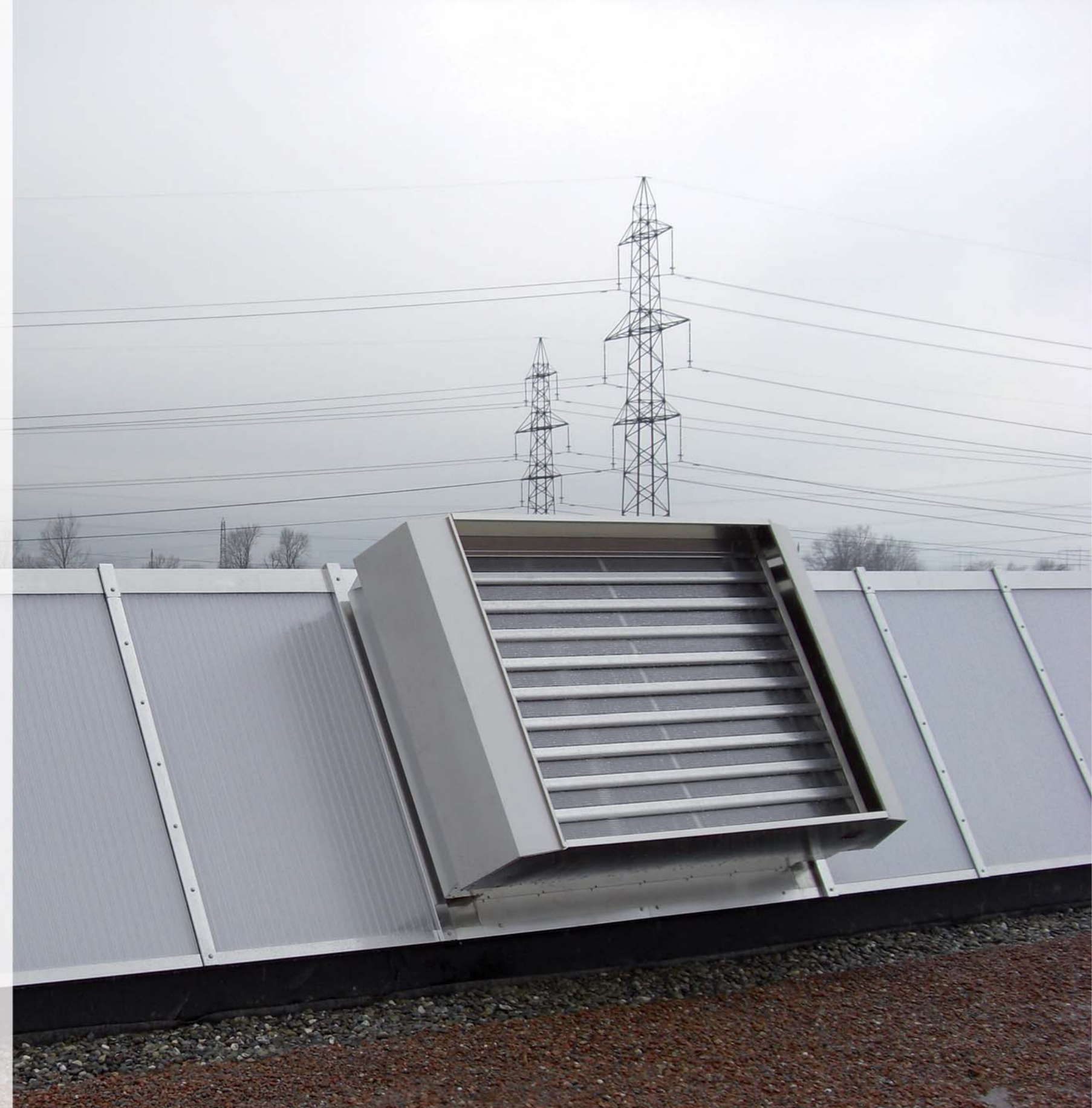
Großes Bild: MULTIJET mit PC-Lamellen in ein DELTALIGHT integriert
