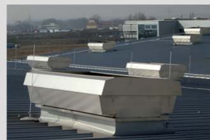
Einzelgeräte auf einer Industriehalle
