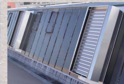
MULTIJETs in einer Shedverglasung
