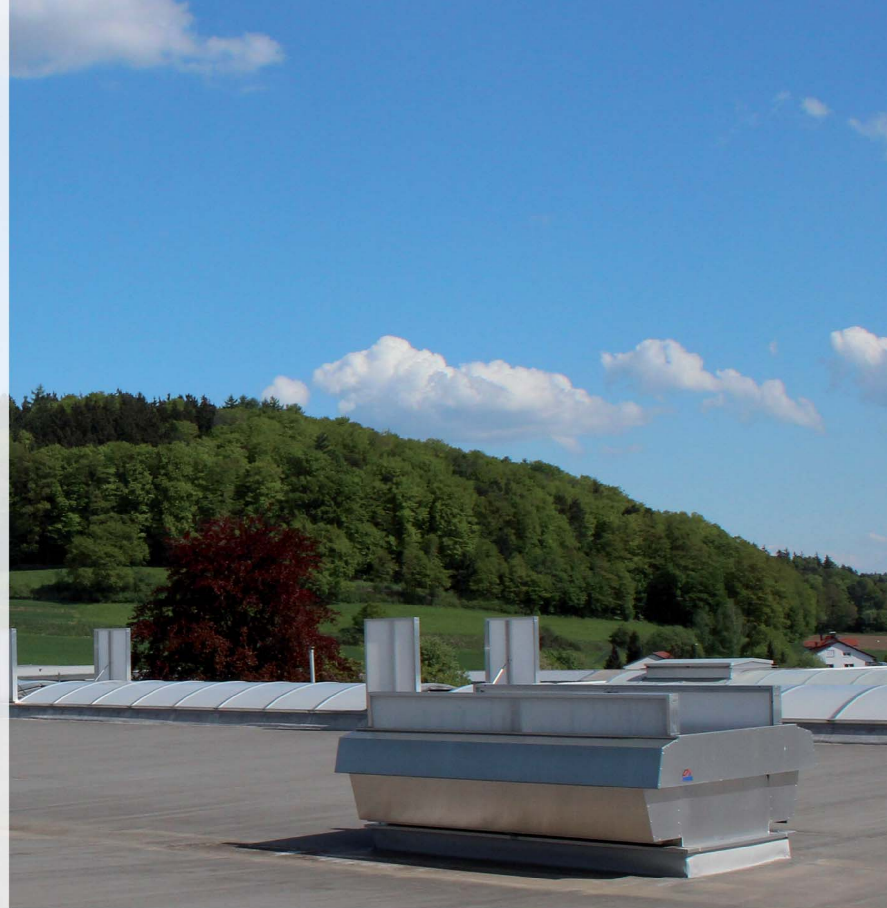
Großes Bild: MEGAPHÖNIX als Einzelgerät auf einer Industriehalle
