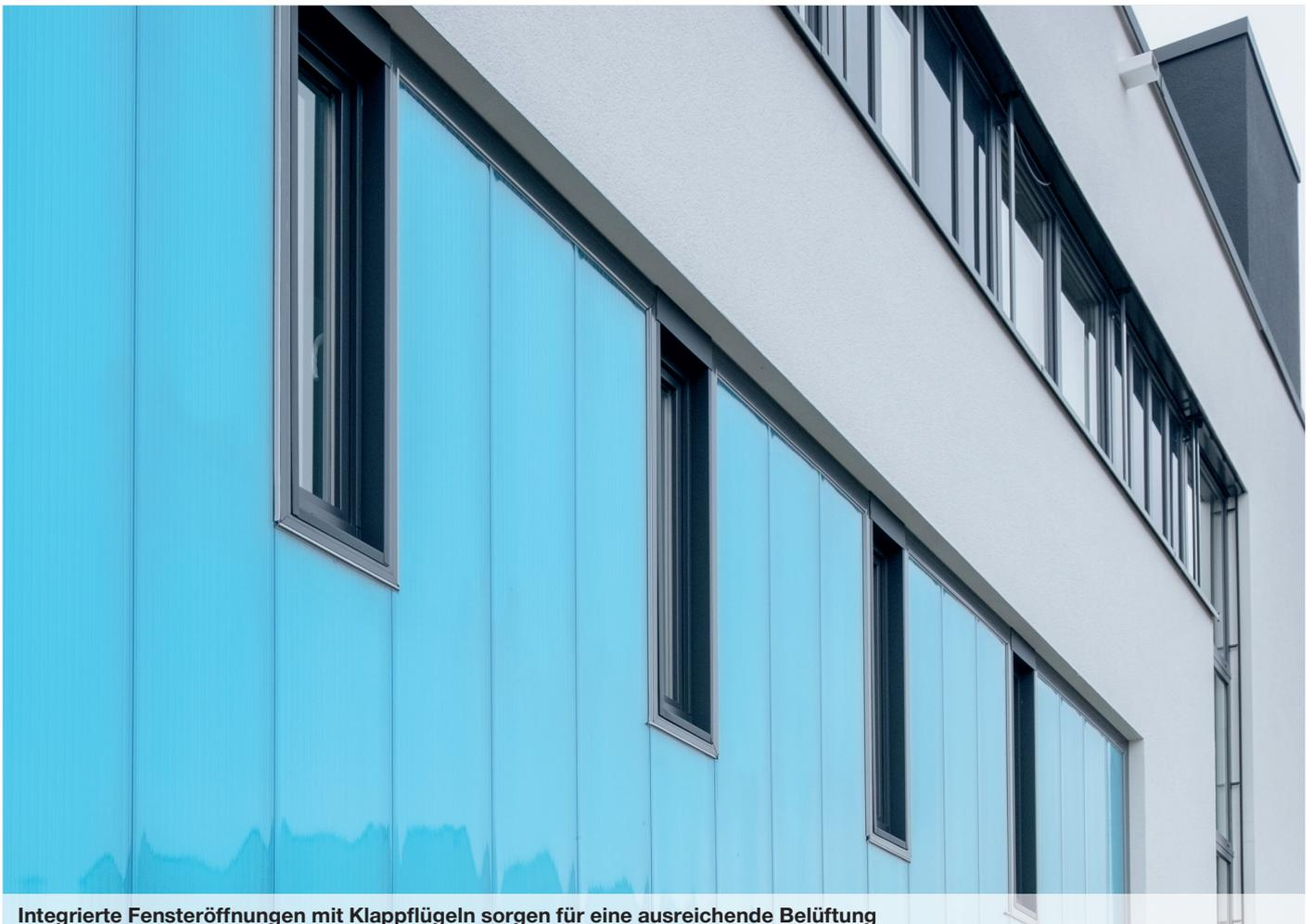
**Integrierte Fensteröffnungen mit Klappflügeln sorgen für eine ausreichende Belüftung**
