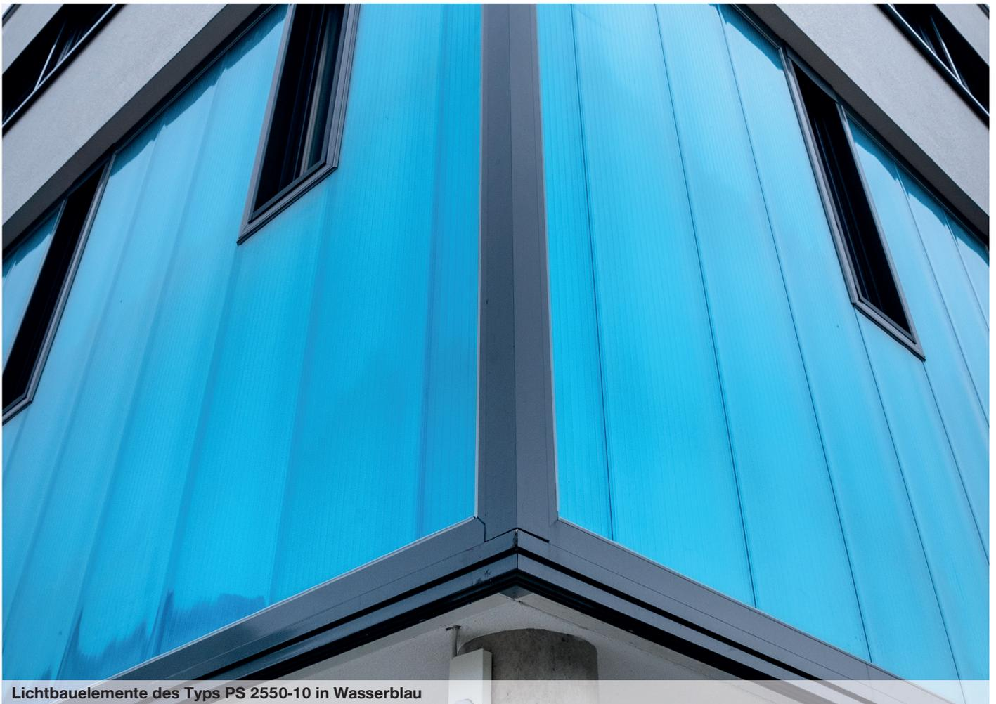
Lichtbauelemente des Typs PS 2550-10 in Wasserblau
