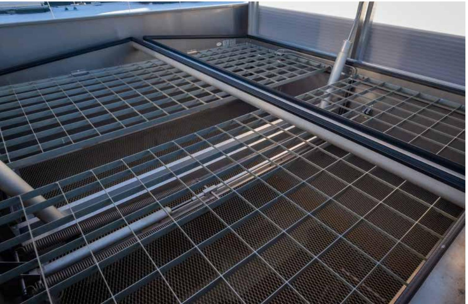
Durchsturzgitter für mehr Sicherheit auf dem Dach bei Reinigungs- und Wartungsarbeiten und Insektenschutzgitter für Hygieneschutz
