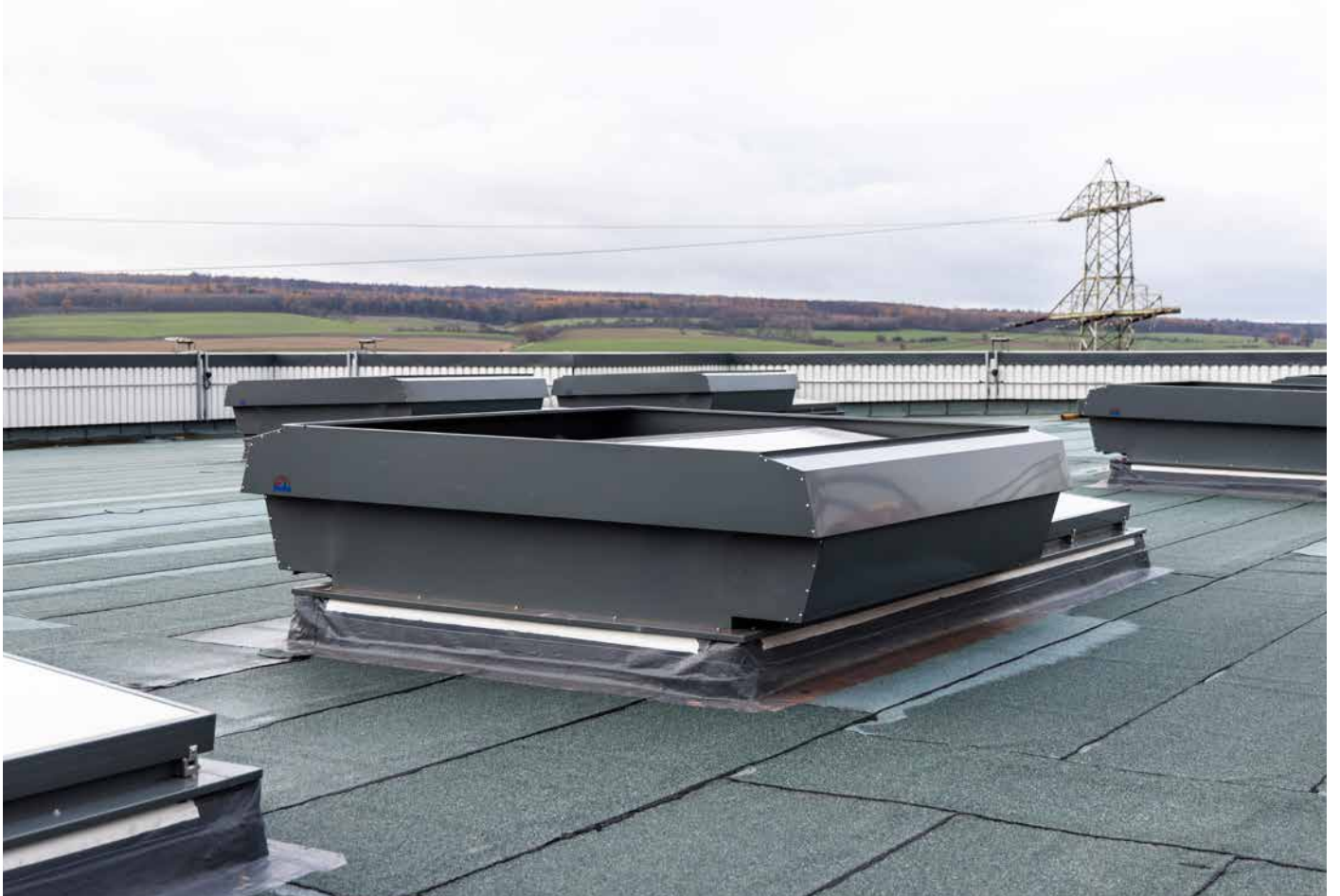
Mehrzwecklüfter des Typs MEGAPHÖNIX für den wetterunabhängigen Luftaustausch
