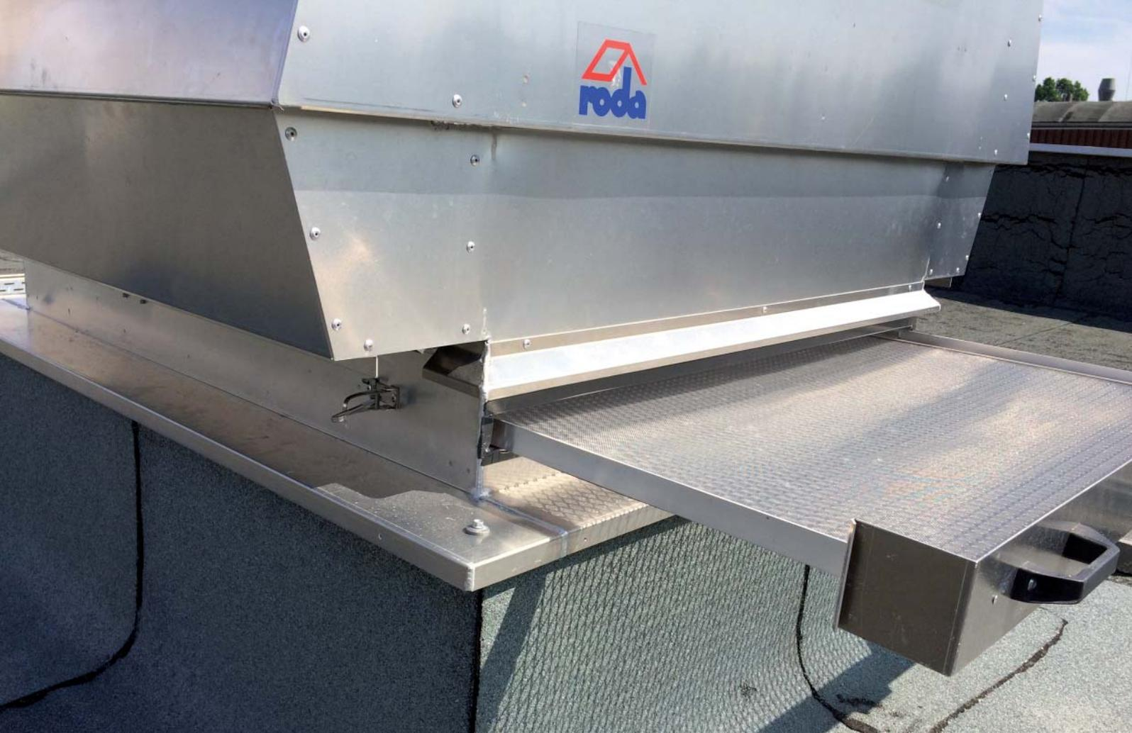
In geschlossenem Zustand wird die Schublade über Spannverschlüsse arretiert
