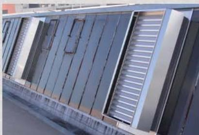
Schräge Einbaulage im Sheddach
