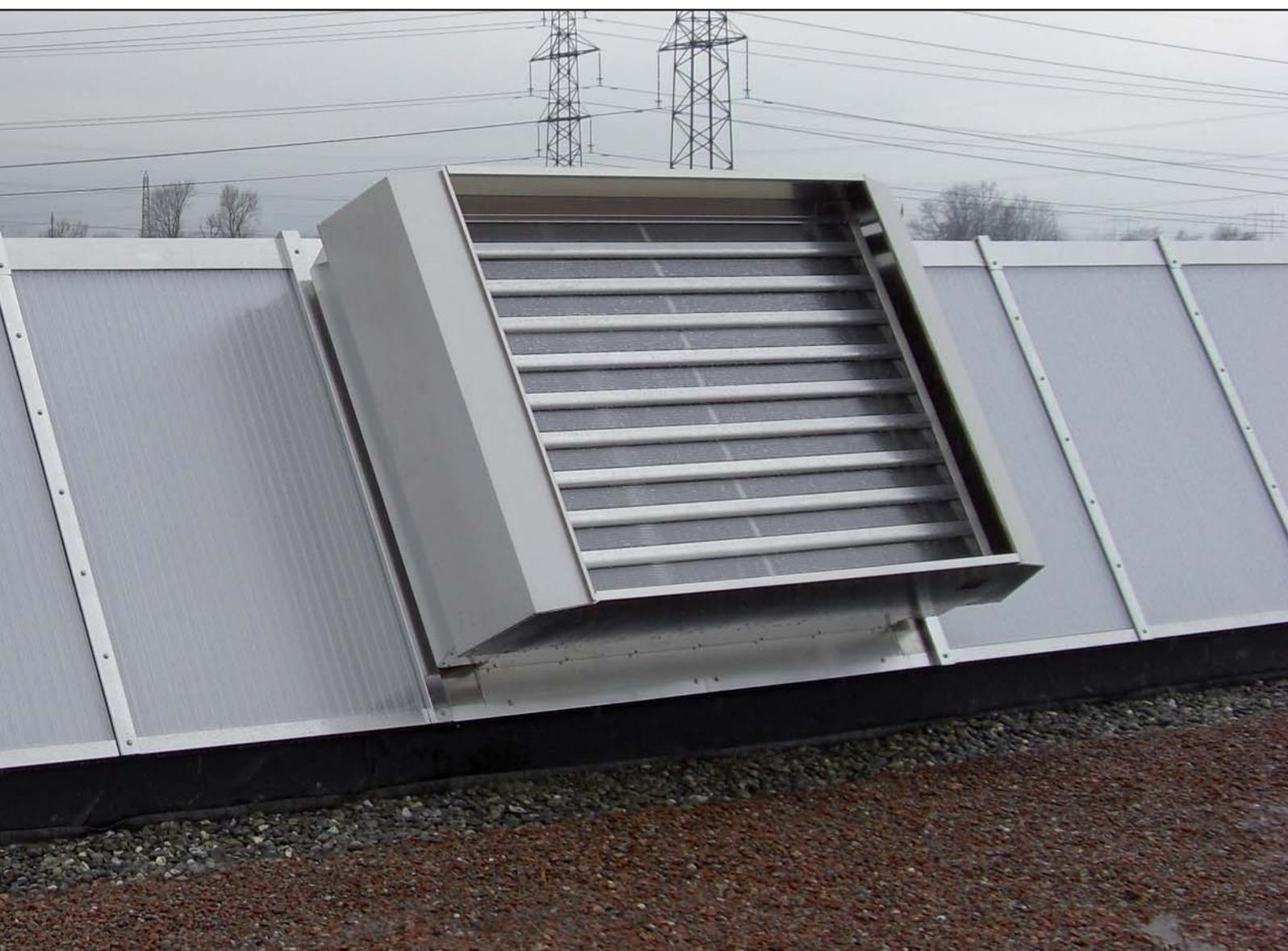
Großes Bild: MULTIJET mit PC-Lamellen als Lüftungsggerät in ein DELTALIGHT integriert.
