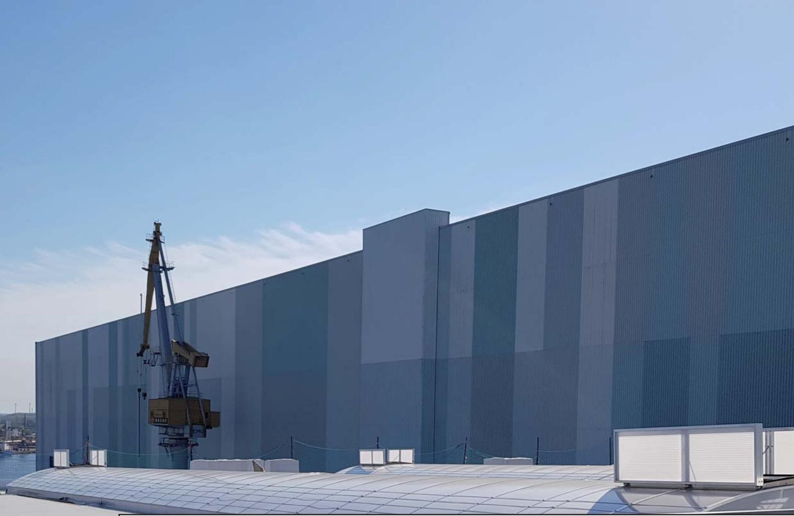
Beim Lichtband sorgen Aluminiumleisten in einem Abstand von 30 cm für die Durchsturzicherheit.
