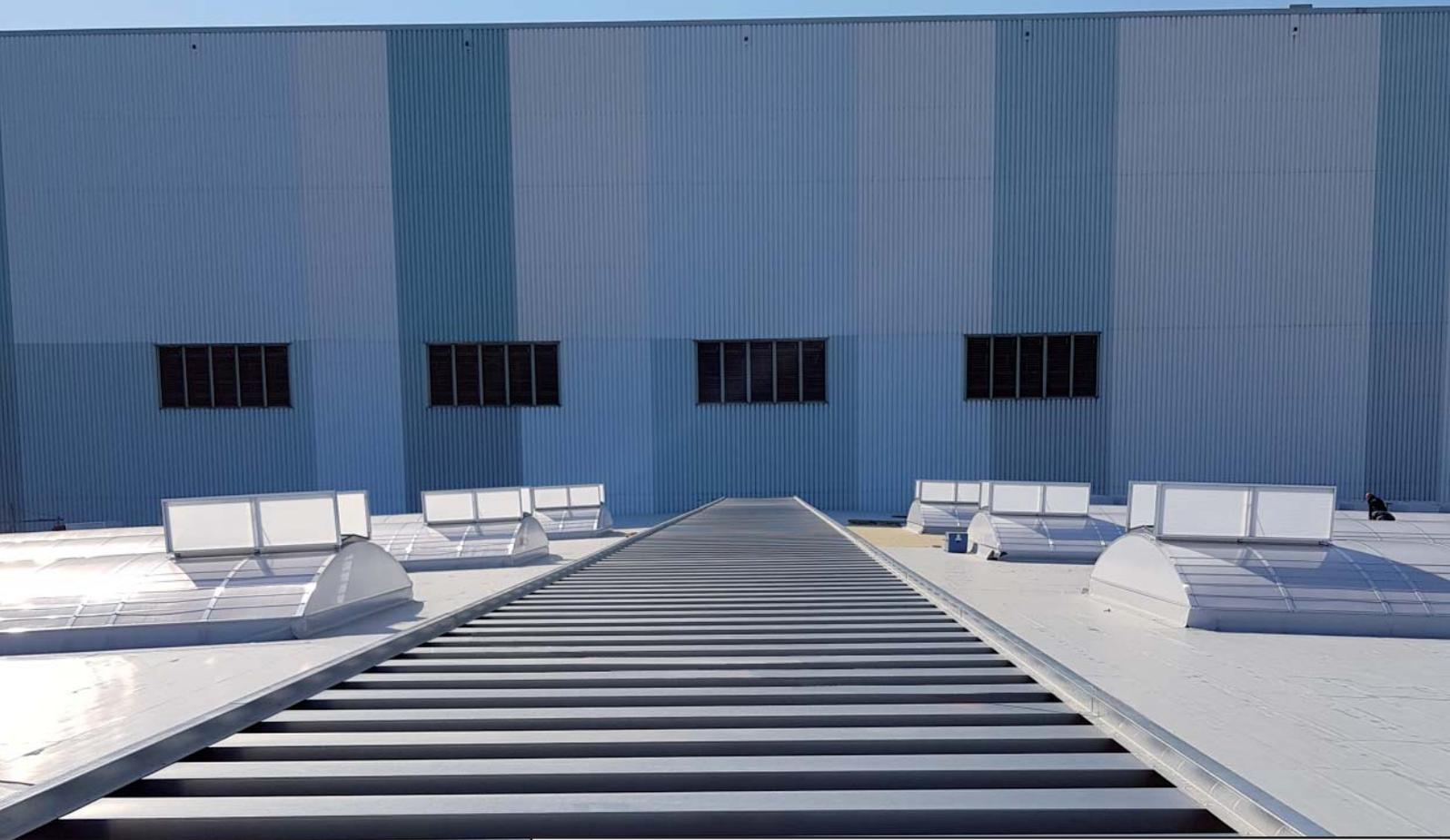
Der Labyrinthlüfter Typ AIRSTAR kann in endloser Länge verbaut werden.
