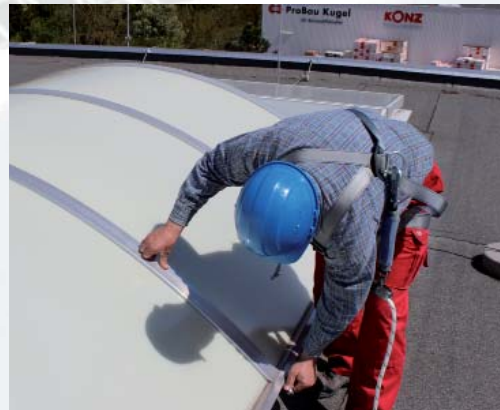
Monteure tragen auf dem Dach Personenschutzgurte, die über ein Seil am Einzelanschlagpunkt befestigt werden.
