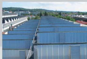
Mit Flansch auf ein Sheddach montiert
