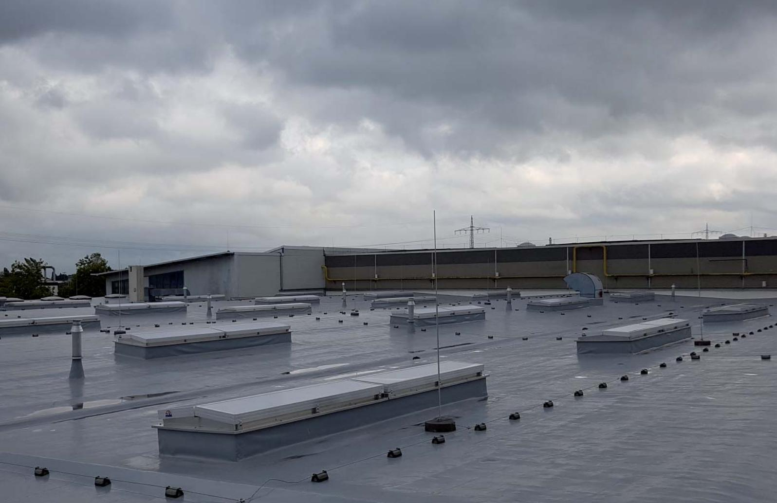
Je ein als RWA- und Lüftungssystem funktionierendes und ein starres System wurden auf den Sockeln installiert
