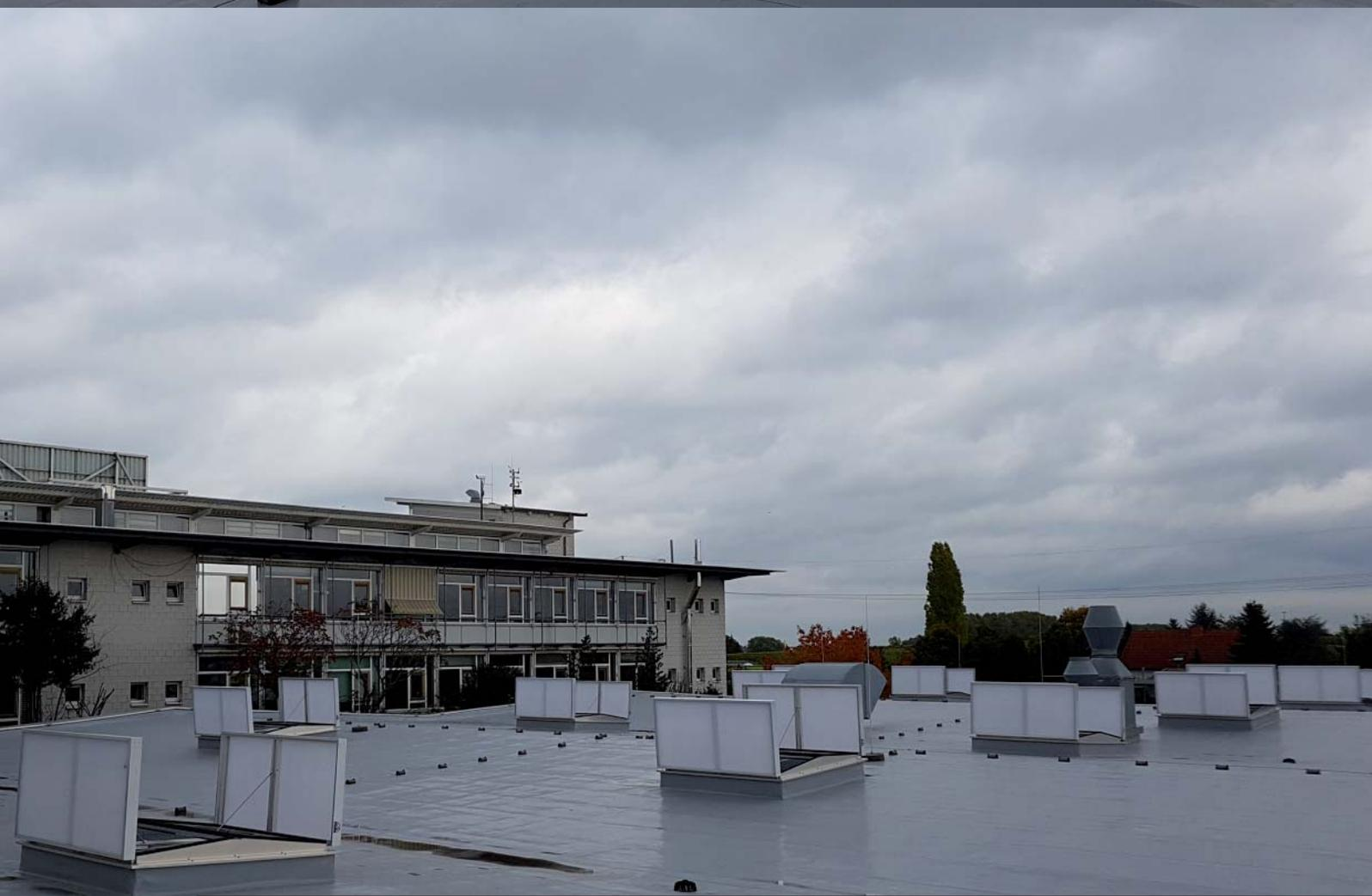
Die kleineren Lichtkuppeln wurden ebenfalls durch auf Maß gefertigte Systeme Typ PHÖNIX ersetzt
