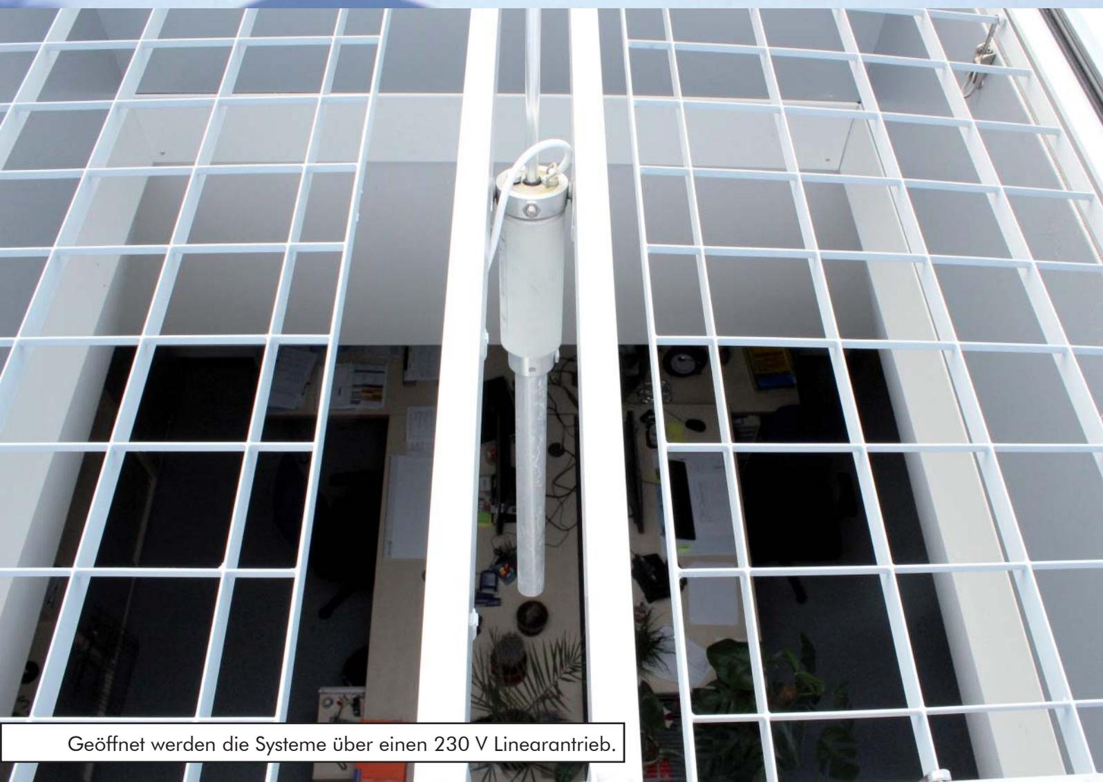
Geöffnet werden die Systeme über einen  $230 \text{ V}$  Linearantrieb.
