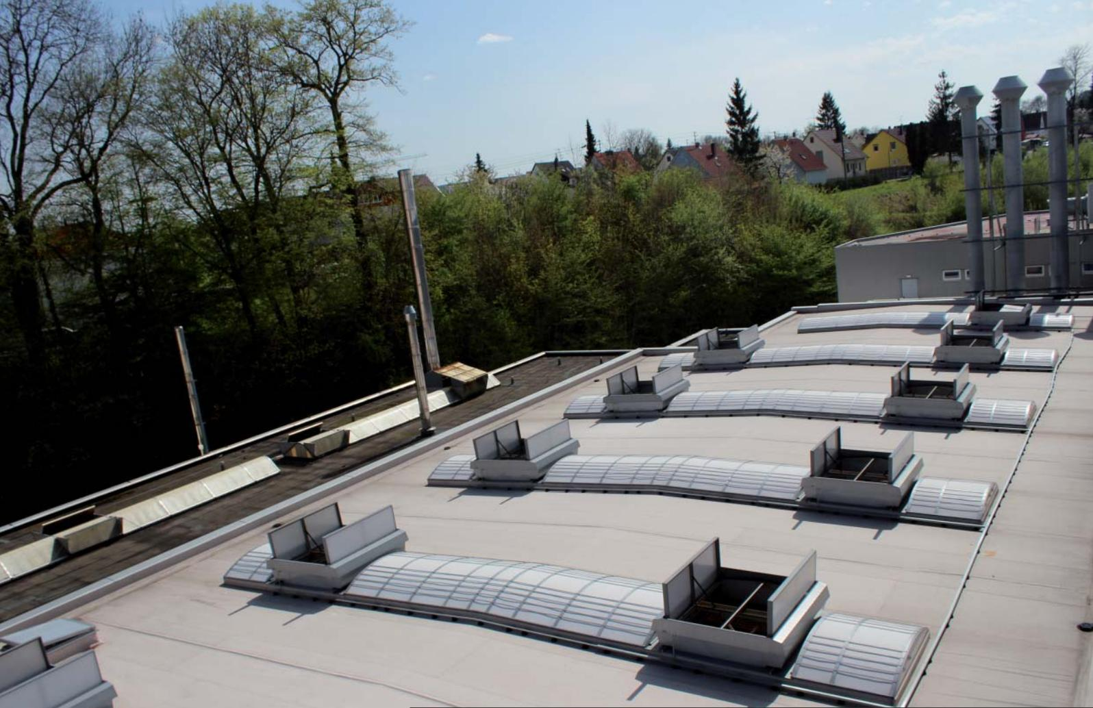
Je zwei Systeme Typ MEGAPHÖNIX wurden in ein Lichtband integriert.
