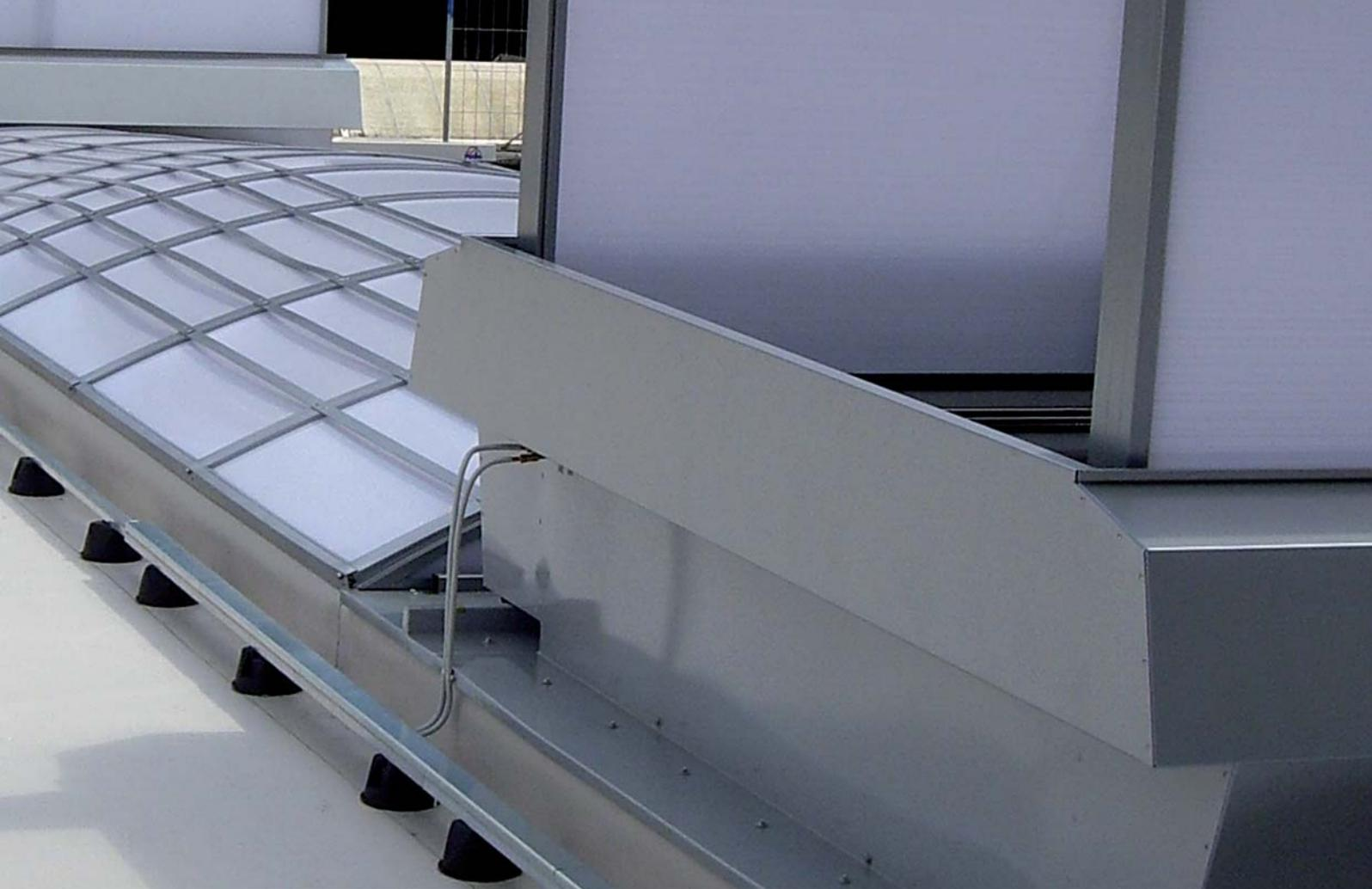
Die Zuleitungen wurden aus dem System geführt und in Kabelkanälen über das Dach verlegt.
