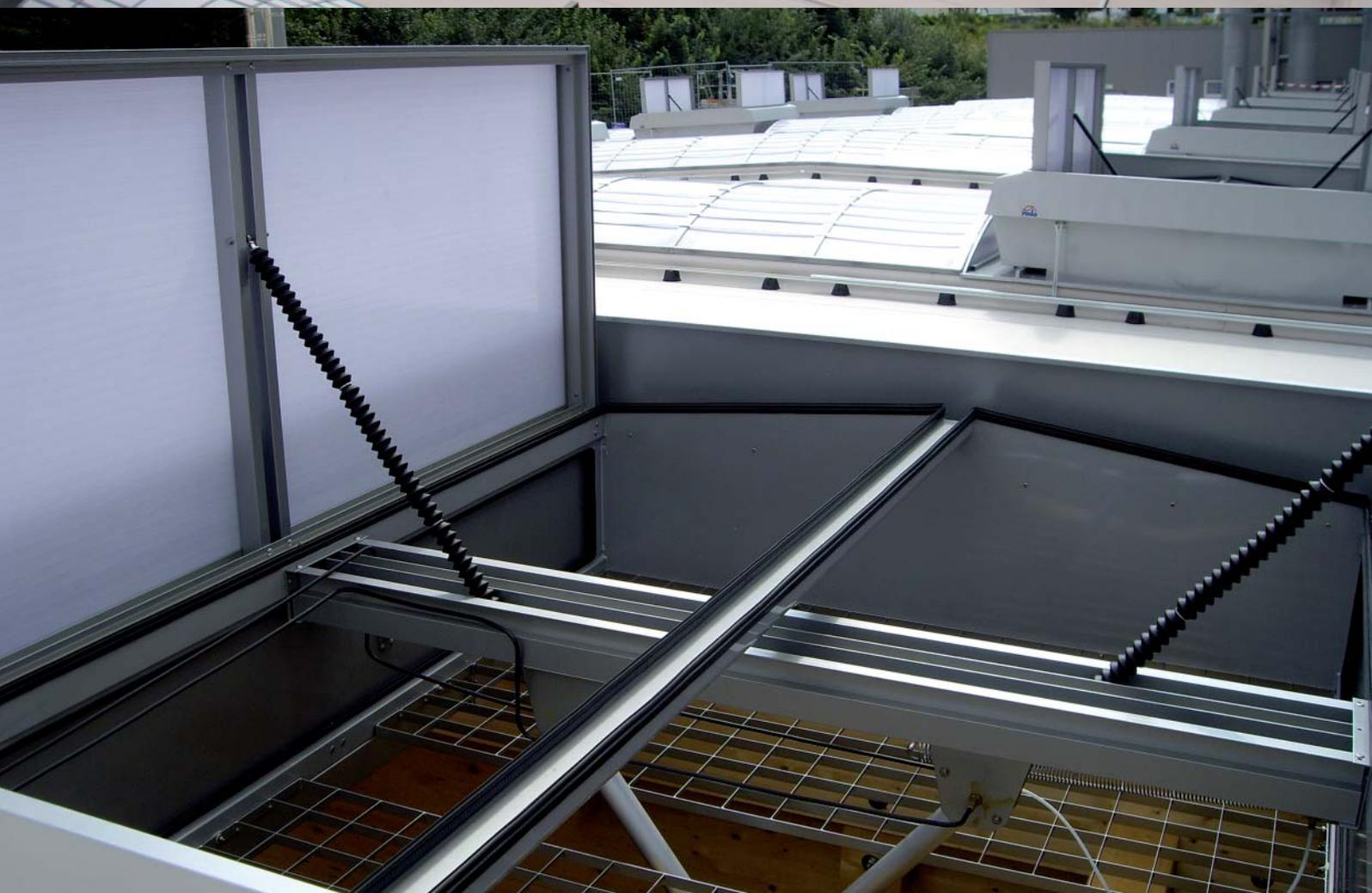
Spezialzylinder mit Faltenbalg und hartverchromter Kolbenstange. Die Zuleitung im System ist aus Kunststoff.
