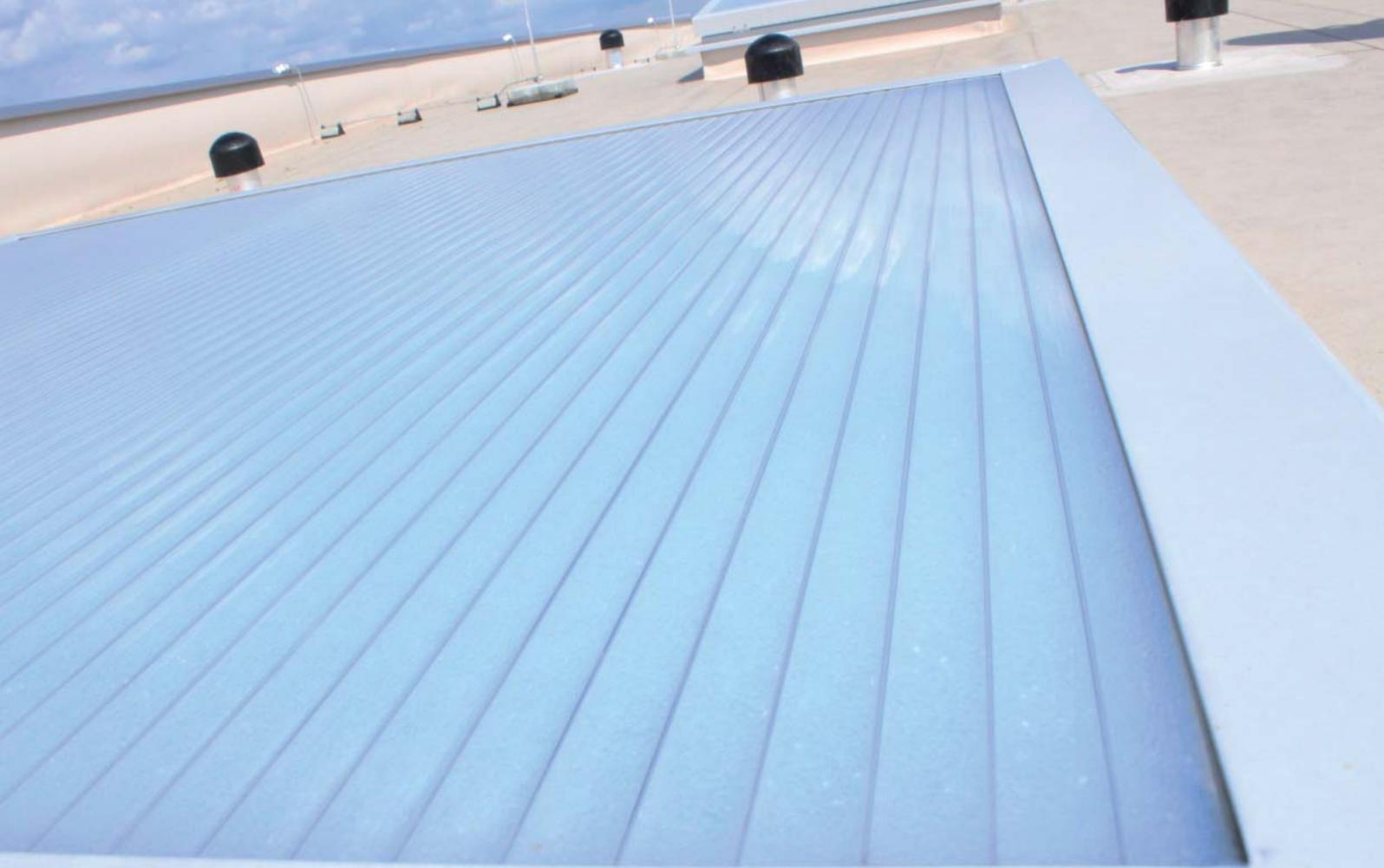
Die Lumira-Füllung bringt die PC-Ausfachung auf einen U-Wert von  $1,33 \text{ W/m}^2\text{K}$ .
