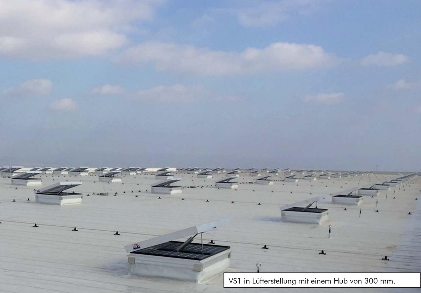
VS1 in Lüfterstellung mit einem Hub von 300 mm.
