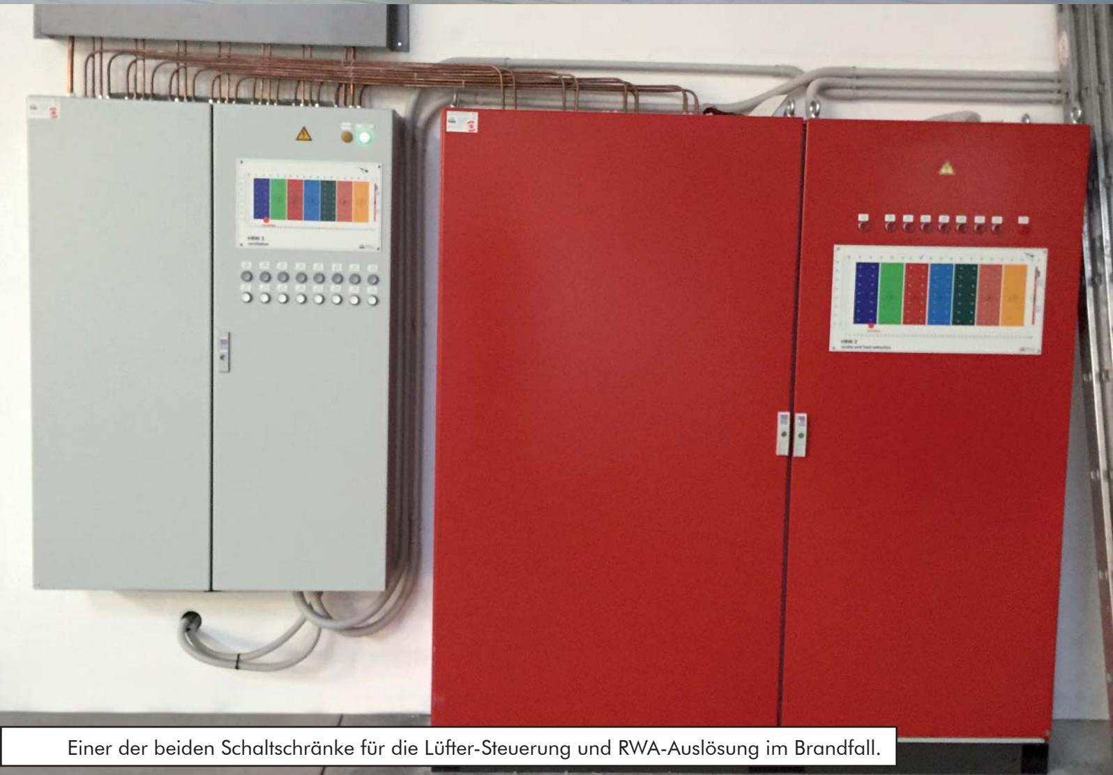
Einer der beiden Schaltschränke für die Lüfter-Steuerung und RWA-Auslösung im Brandfall.
