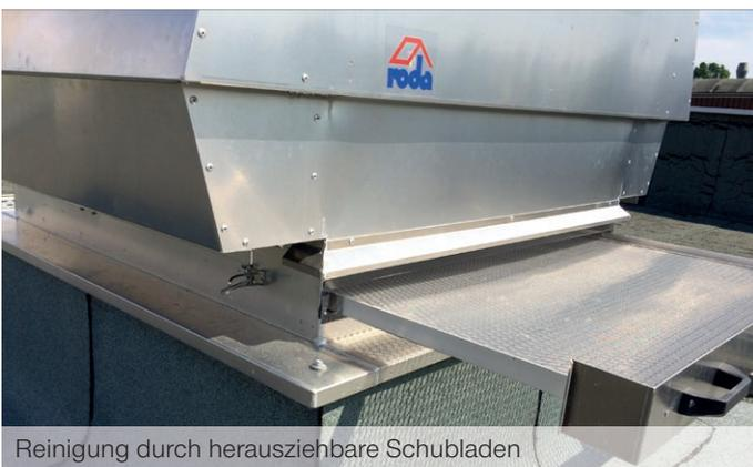
Reinigung durch herausziehbare Schubläden
